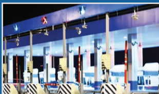
Controllo degli accessi
